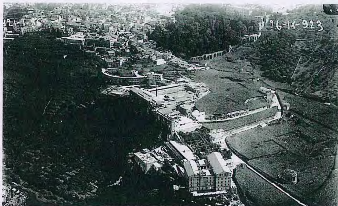
1923. Ripresa aerea della zona industriale, il parco di Villa d'Este, parte del quartiere medioevale e i magnifici pergolati della zona Gaudente in piena vigoria. In basso sulla sinistra l'antica strada dell'Acquoria, ancora transitabile a tutti. (Uff. Doc. e A.P. 26/9/1923 cat. 14197 Aeronautica Militare).
