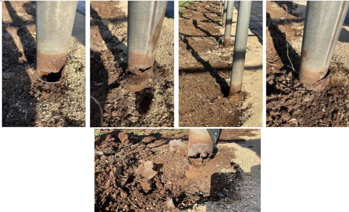
La stabilità della struttura risulta seriamente compromessa, pertanto, si reputa opportuno consolidare tutti i pali di sostegno laterali delle strutture con un cordolo di cemento armato che ingloba gli stessi al fine di dare stabilità alle serre.
